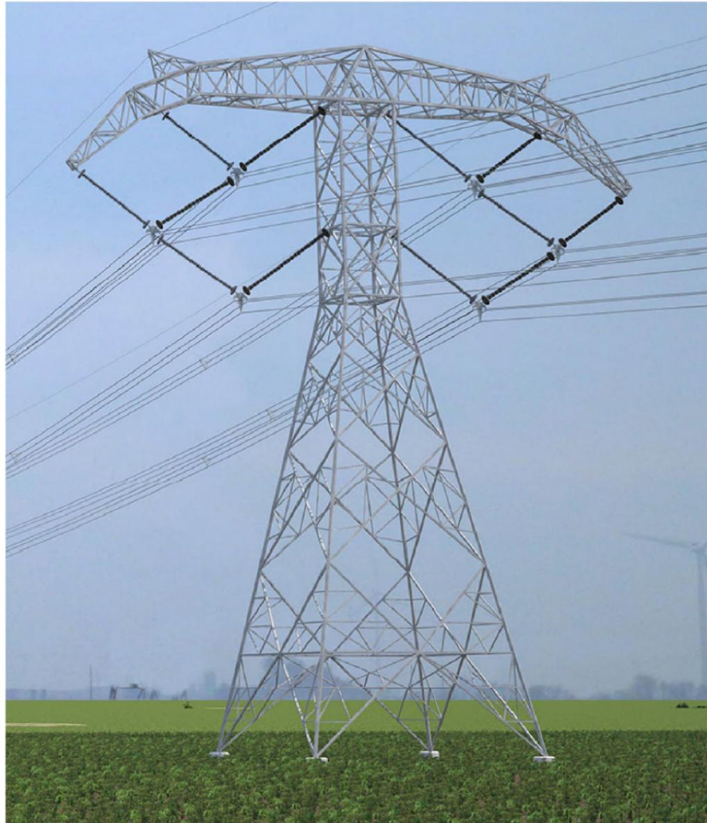
El proyecto incluye la tecnología BOLD (Breakthrough in Overhead Line Design – Un avance en el diseño de líneas aéreas) de AEP, que son capaces de funcionar de forma más eficiente que los diseños de postes de transmisión convencionales.
